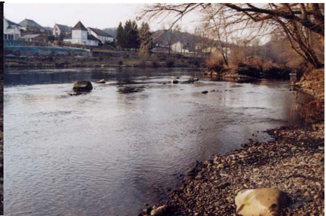
Photo 13 : le même site à 32 m 3 /s en 2005 après travaux
